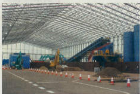
大熊②工区(清水JV) ※2施設
