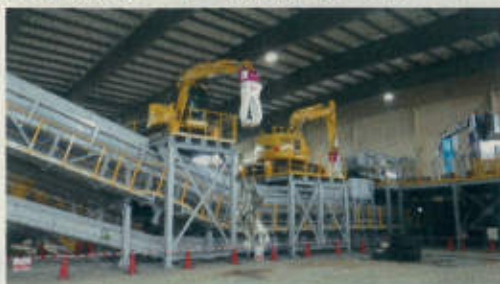
大熊①工区(鹿島JV)
